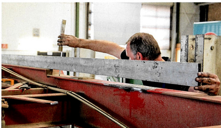
Immer wieder sucht sich der Richtmeister nicht verformte Baugruppen oder Träger, an denen er sich orientieren kann.
