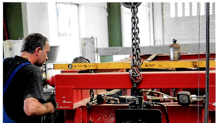
Augenmaß ist gefragt. Die Fortschritte beim Richten lassen sich oft nur schwer messen. Fluchtlatten dienen als Orientierungshilfe.
